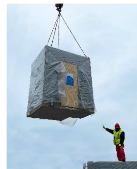
Instalace modulární koupelny, Happi Milánská
