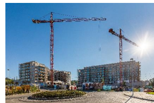
Hrubá stavba Lappi Hloubětín
