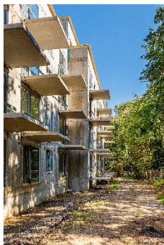
Hrubá stavba Vesi Hostivař
