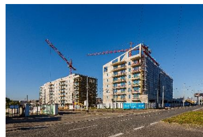
Hrubá stavba Lappi Hloubětín
