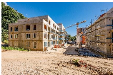
Hrubá stavba Vesi Hostivař
