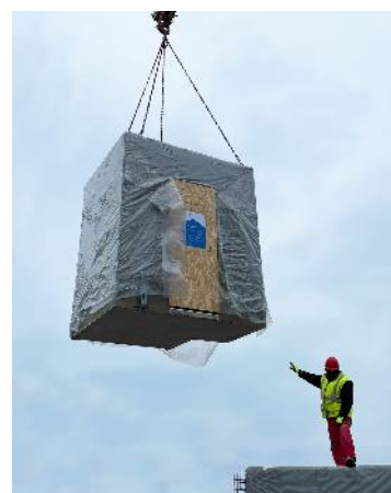
Instalace modulární koupelny (projekt Happi Milánská)
