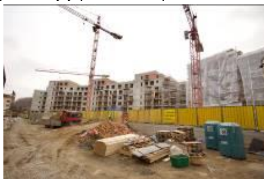
Dokončená hrubá stavba rezidence Aalto Cibulka společnosti YIT
