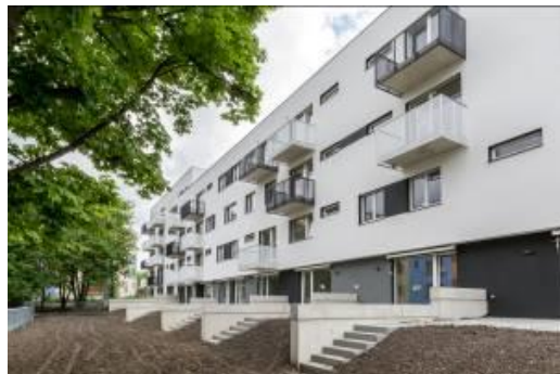
Bytový projekt společnosti YIT KOTI Hostivař.
