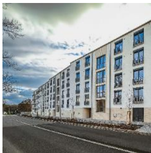
Zkolaudovaný projekt Koti Libeň
