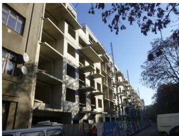
Hrubá stavba Talo Kavalírka
