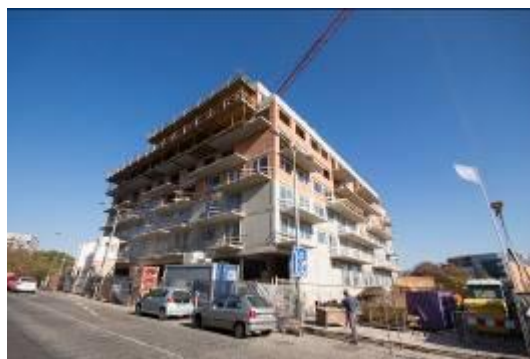
Hrubá stavba bytového domu Koru Vinohradská společnosti YIT
