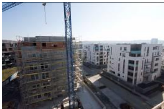
Hrubá stavba čtvrté etapy Lahti rezidenčního komplexu Suomi Hloubětín společnosti YIT
